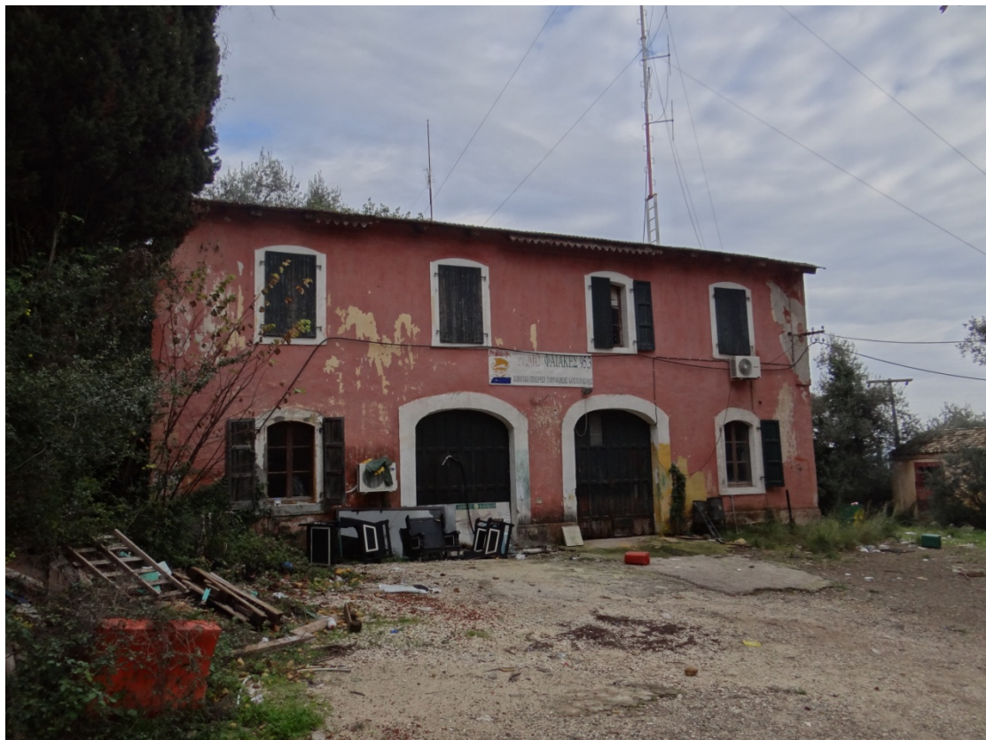
Φωτογραφία 7. Αποψη του υφιστάμενου κτίσματος Θ στο βόρειο άκρο της περιοχής εφαρμογής από την θέση Θ5
