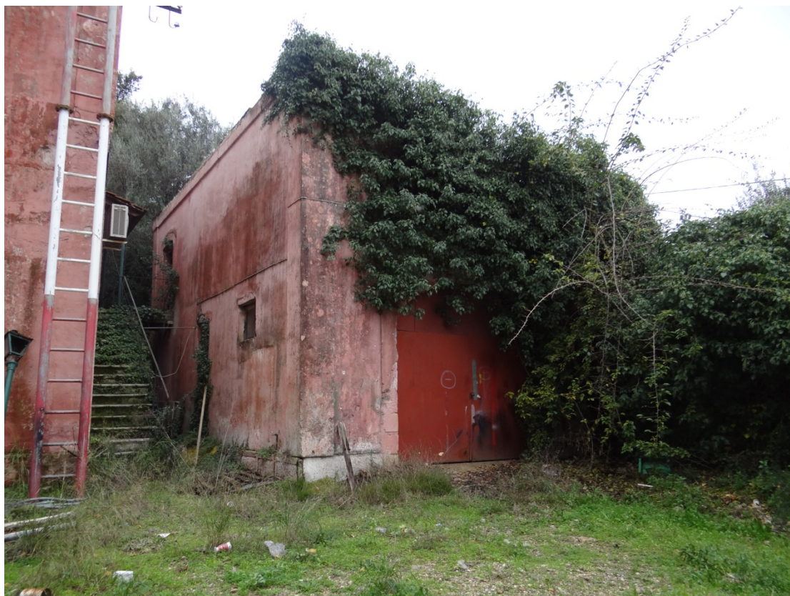
Φωτογραφία 8. Άποψη του υφιστάμενου κτίσματος Η από την θέση Θ6
