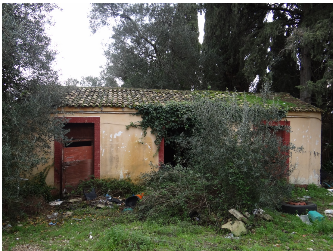
Φωτογραφία 9. Άποψη του υφιστάμενου κτίσματος Ζ από την θέση Θ6
