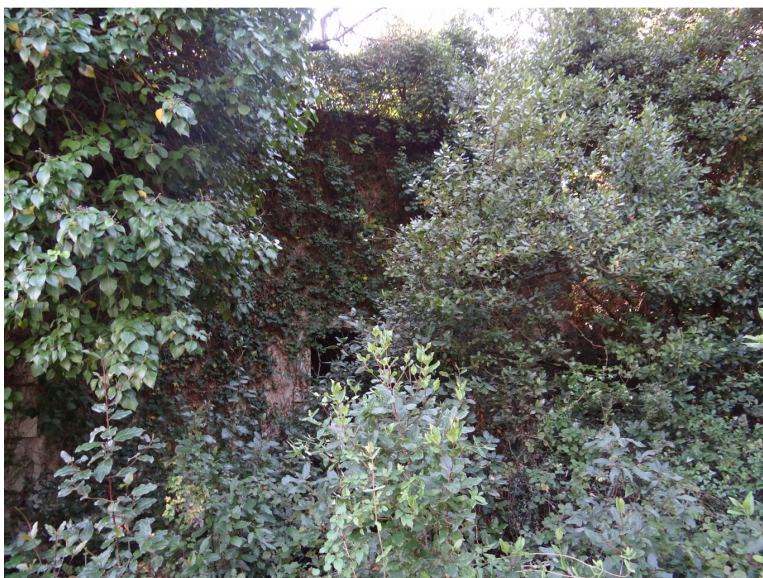
Φωτογραφία 31. Αποψη προς Ν του υφιστάμενου κτίσματος Ι από την θέση Θ23
